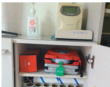
ライスペーパー工場に設置されたオムロンのAED。この工場では外の救急時にも対応できるよう入口玄関に設置されている。
